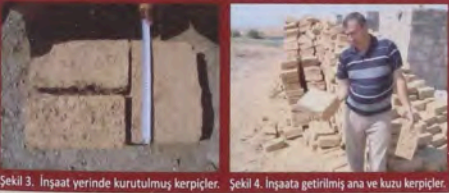
Şekil 3. İnşaat yerinde kurutulmuş kerpeçler. Şekil 4. İnşaata getirilmiş ana ve kuzu kerpeçler.
