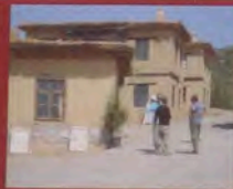
Şekil 6. Yapımı tamamlanan tek ve iki katlı konutlar
