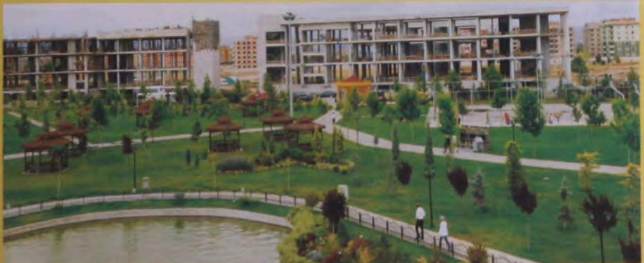
Rektörlük, eğitim bloğu, kütüphane ve yemekhane kaba inşaatı tamamlandı.
