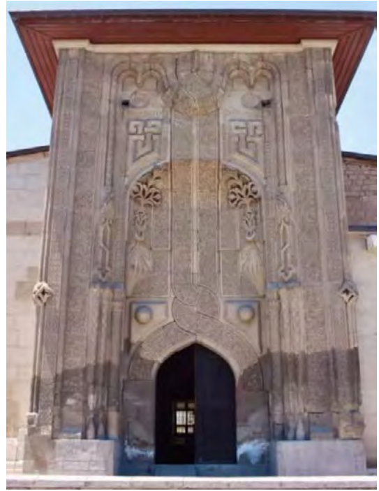
Fotoğraf 2: İnce Minare Medresesinin Taç Kapısı.
